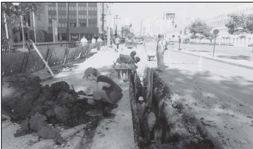
Monitoramento arqueológico na Av. Cândido de Abreu, em Curitiba. Na foto: Roseli S. Ceccon, Daniel Maoski (estagiário) e operários da obra (2002).
