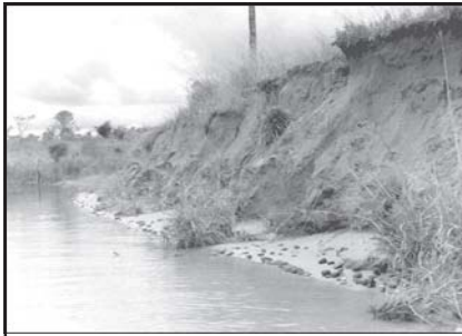
Foto 3. Erosão causada pela oscilação de águas do reservatório da UHE Rosana, na área do sítio PR TR 12, com deslocamento de peças arqueológicas (Foto: J. E. Volcov - 1990).
